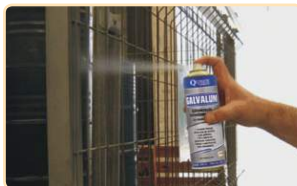
Grade em aço sendo galvanizada com Galvalum.
