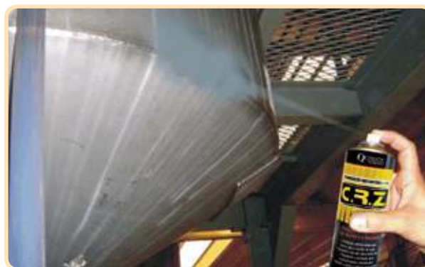
Retoque com C.R.Z na solda do tanque galvanizado.
