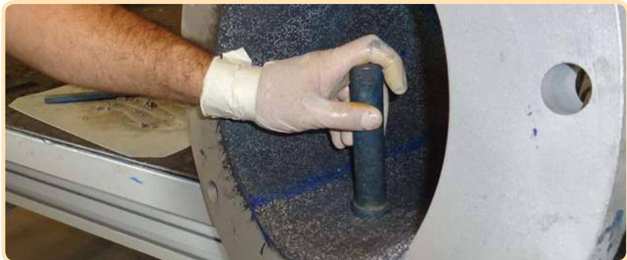
Proteção de Bomba com Plasteel Diamantado.
