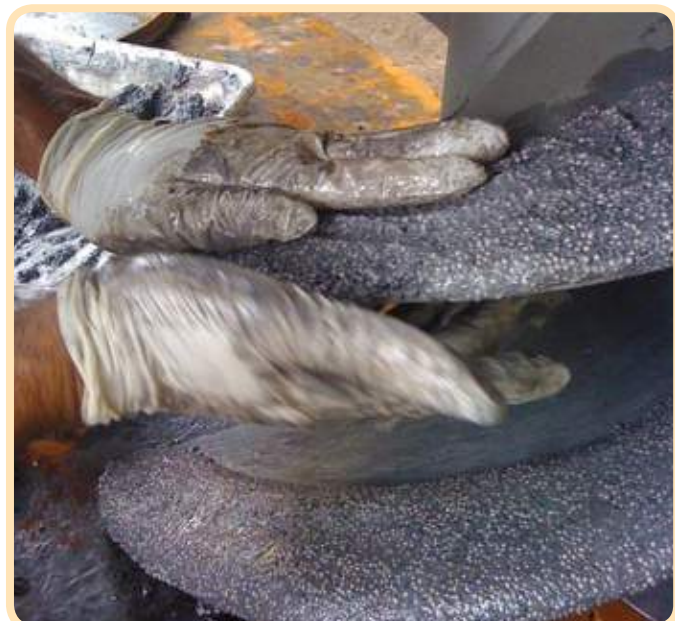
Recuperação de Rosca Transportadora com Plasteel Diamantado.
